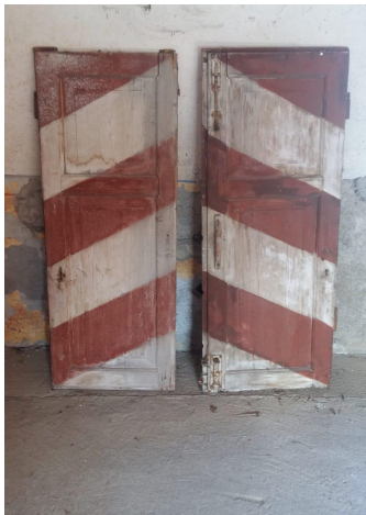
Restauro dei serramenti e delle ante ad oscuro
