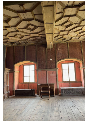
Sala del Vescovo: rivestimento parietale e restauro del soffitto
