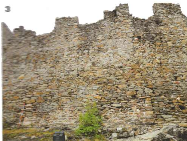
3. La struttura muraria di primo periodo con tessitura ad elementi inclinati.
