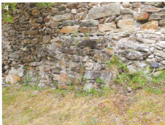
4. L'anomalia muraria inglobata alla base della cinta duecentesca.
